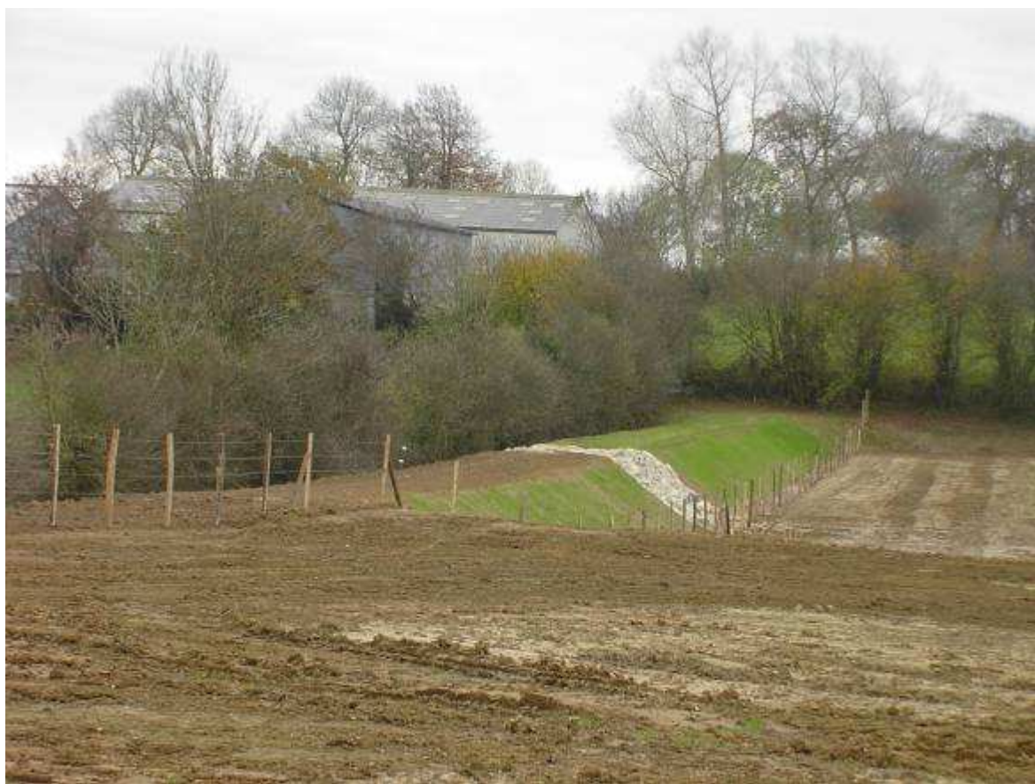
(Photo : ouvrage de Wicquinghem)
